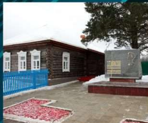
Дом В.Кулик в д. Петрищево, где Зоя провела последнюю ночь перед казнью. Отреставрирован РВИО в 2016 г.
